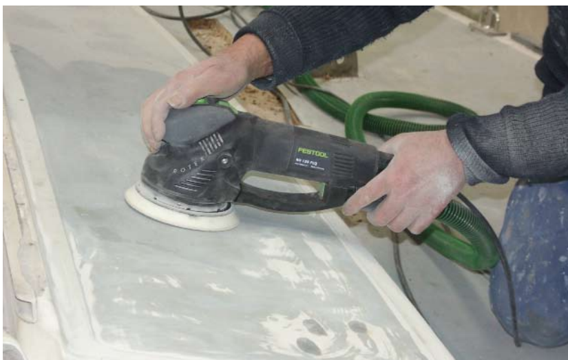
Mandarf nicht mit zu grobem Gerät zu Werke gehen, um auch nach dem Schleifen noch eine möglichst plane Oberfläche zu haben. Exzenterschleifer haben sich hier bewährt.
