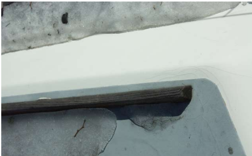
Frost beschleunigt die Zerstörung einer feuchten Sandwichkonstruktion durch hohen Druck, der die Schichten auseinandersprengt.
